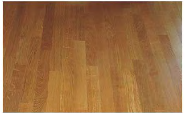
Parquet listone di Padouk prefinito marca "STILE Pavimenti in Legno" misura 90x10 cm. posato a tolda di nave.
